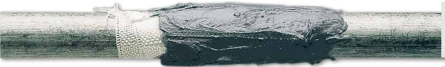
Brzi popravke cevovoda
